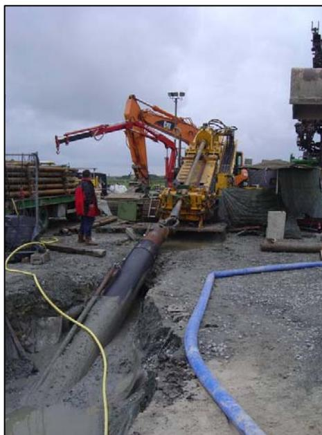
Bild 4: Eingezogenes Produktenrohr mit nebenliegendem Bohrgestänge
